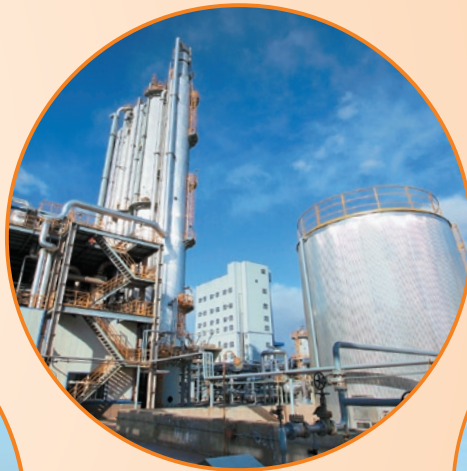
位於內蒙古之 煤制甲醇廠 開始投產
