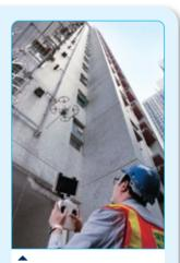
「立管檢查飛行器」是改裝自遙控直 昇機,並裝設了高清數碼鏡頭及伸 縮式氣體探測儀,減少技術員於棚 架上進行高空工作。
