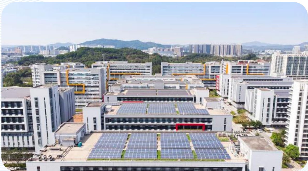
佛山工业厂房5.5MW分布式光伏发电项目
