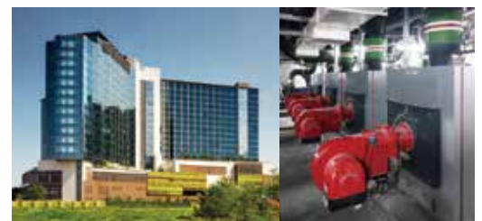
▲ 東涌世茂喜來登酒店與福朋喜來登酒店均安裝了煤氣熱水鍋爐供中央熱水系統及暖水泳池使用。
