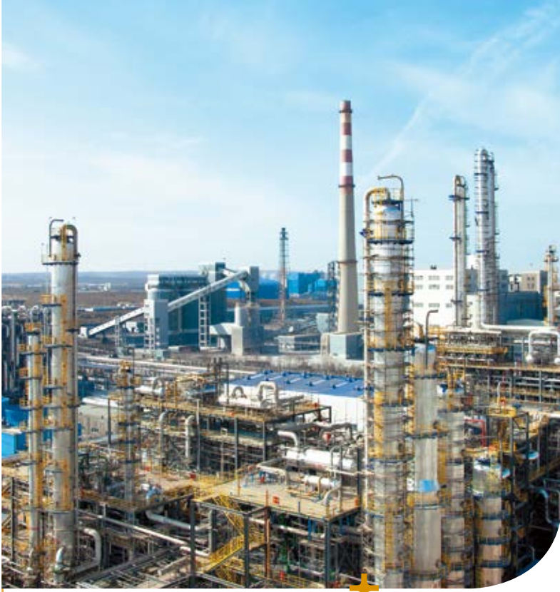
位於內蒙古自治區鄂爾多斯市之乙二醇設施 建設工作已於2017年完成。
