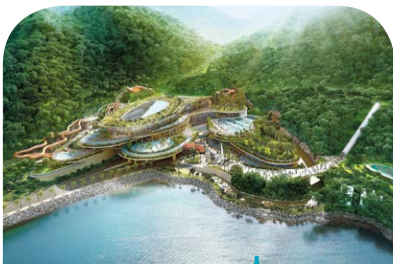
海洋公園全新水上樂園項目，將採用直燃型吸收式冷熱水機組，為室內提供冷暖空調。
