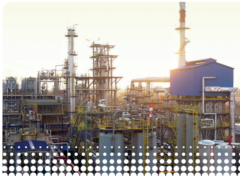
位于江苏省张家港的氢化植物油厂房。
