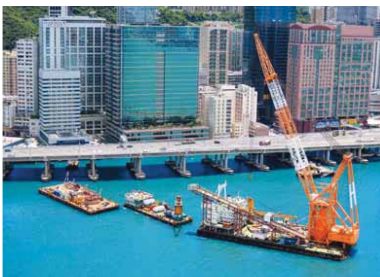
為配合政府之東南九龍發展計劃，我們為連接土瓜灣與北角之雙海底管道進行改道工程。
