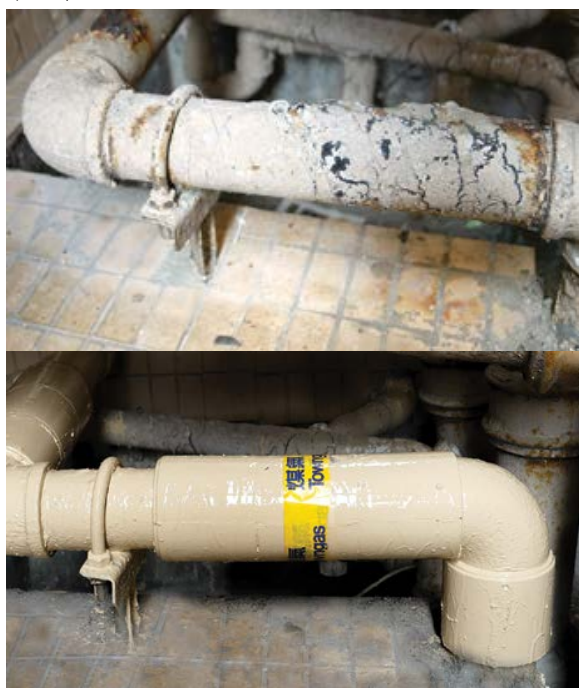
煤氣公司自行研發「聰明立管外套」修補銹蝕煤氣立管，減少七成更換立管所需的鋼鐵物料。
