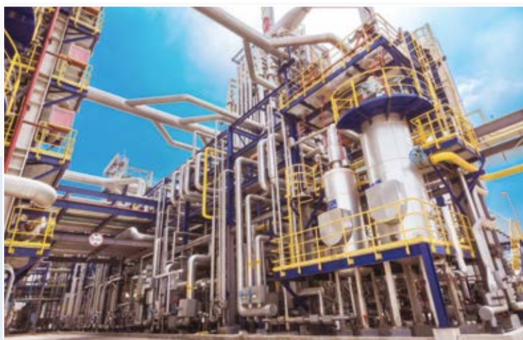
▲ 集團位於江蘇省張家港市的氫化植物油廠房。
