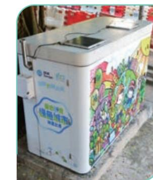
我們開發智能調壓器提高營運效率，運用先進的窄頻物聯網(NB-IoT)技術進行無線數據傳輸，發揮低功耗、具成本效益、可遠距離通訊的優勢。調壓器系統可以全天候24小時以監察及實時更新運作情況，毋須僱員到現場檢查，同時亦配備了太陽能供電裝置，更環保及更可持續的方式運作。
