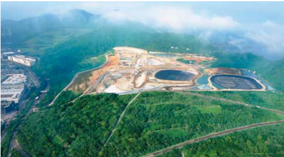
新界東南堆填區沼氣利用項目為本港大型節能減排環保項目之一。
