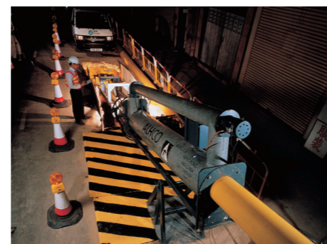
無坑開挖技術 Trenchless technology
